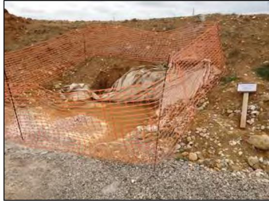
Figure 57 : exemple d'aire de lavage des toupies sur un chantier de parc éolien [source : source : Abies]
