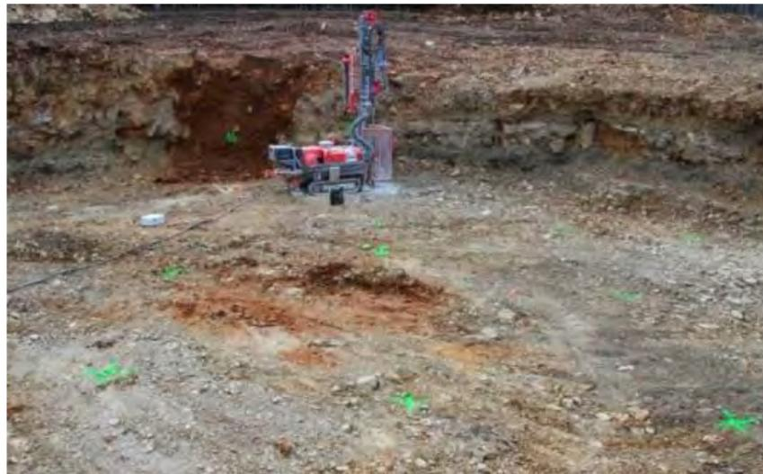
Figure 56 : foreuse géotechnique sur un chantier éolien [source : Abies]
