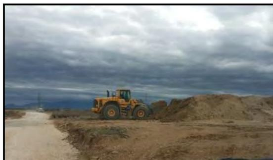
Figure 60 : reprise de la terre stockée pour le remblayage des fondations [source : Abies]
